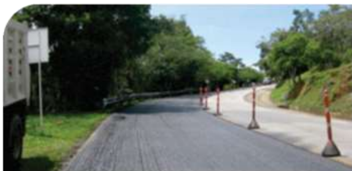
Socorro Ruta 45 A 06; PR: 101 +500 • Fresado
