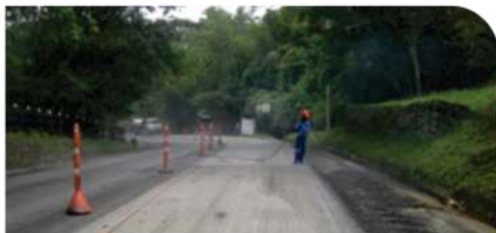
Socorro Ruta 45 A 06; PR: 100+200 • Limpieza de Superficie
