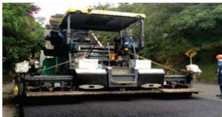
Socorro Ruta 45 A 06; PR: 99+900 • Extensión de Asfalto
